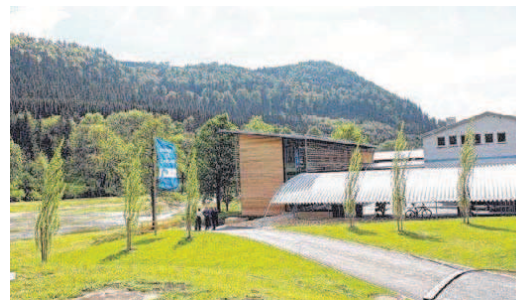
Architektonisch mehr als ein reiner Zweckbau: Das Wasserwerk Hammer zwischen Bärenthal, Egesheim und Nusplingen. FOTOS: RM
